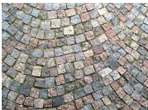
Rys. 2. Kostka granitowa 10x10 cm, kolor mix
